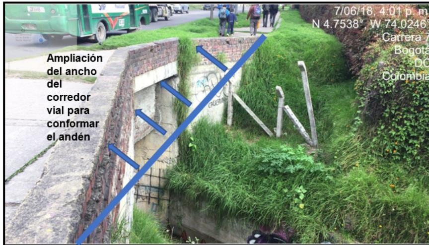
**Fotografía N° 1.** En este lugar se tiene proyectado así: Ampliación del ancho del corredor vial para conformar el andén se ha diseñado una estructura tipo pórtico.
