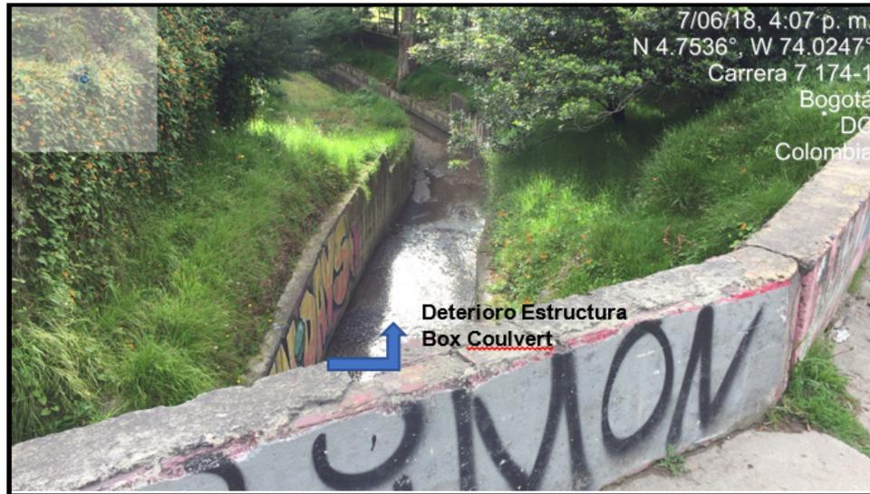
**Fotografía N° 3. Deterioro Estructura Box Culvert.**
